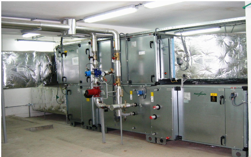
Slika 3.7: Pravilno izvedena izolacija cevodova i kanala za vazduh u mašinskoj sali
