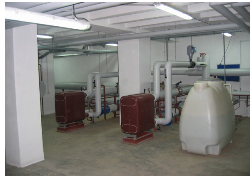
Slika 3.6: Pravilno izvedena izolacija opreme u toplotnoj podstancici
