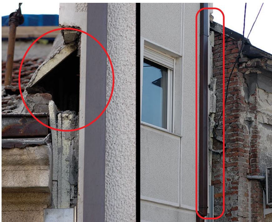
Slika 3.2: Detalji spoljne toplotne izolacije; levo: detalj rupe na levoj strani, desno: detalj neuredno postavljenog stiropora na desnoj strani 23
