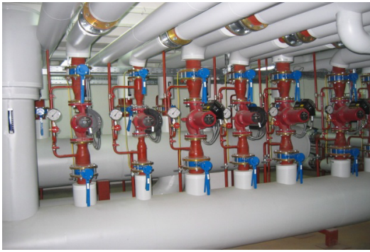
Slika 3.6: Pravilno izvedena izolacija opreme u toplotnoj podstancici
