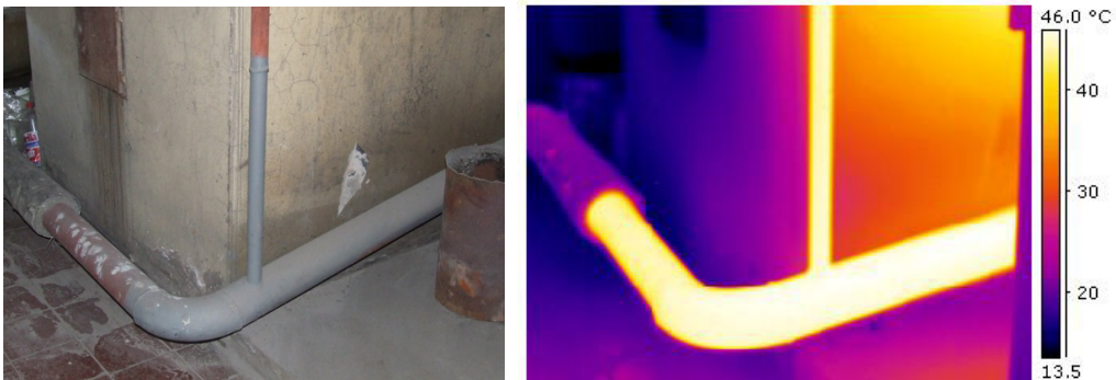
Slika 3.5: Deo cevovoda sistema grejanja koji nije izolovan i termovizijski snimak
